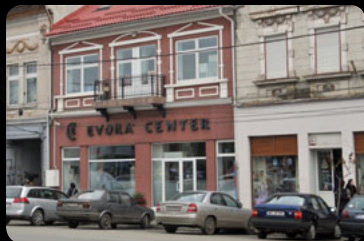
Evora Central - Magazin finisaje + showroom sanitare
